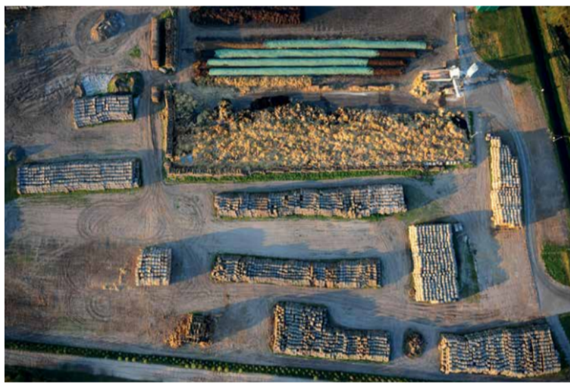
/ W zakładzie przetwarzane są selektywnie zebrane odpady zielone, bioodpady i inne, ulegające biodegradacji.
